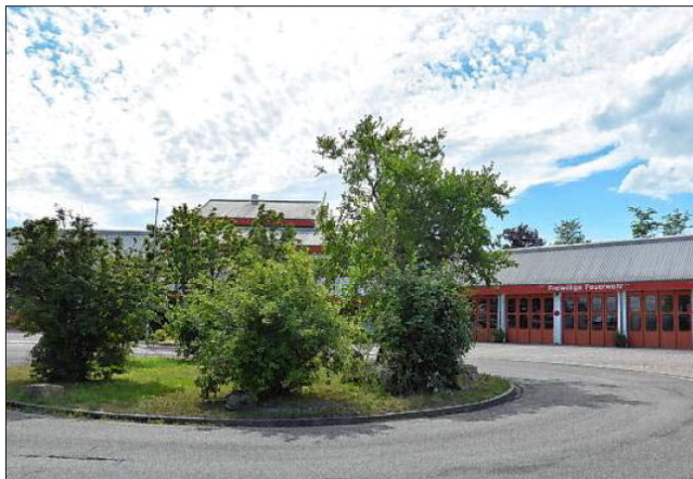
Hier soll er hin, der neue 5G-fähige Mobilfunkmast: auf den Kreisell vor dem Willstätter Feuerwehrhaus.
